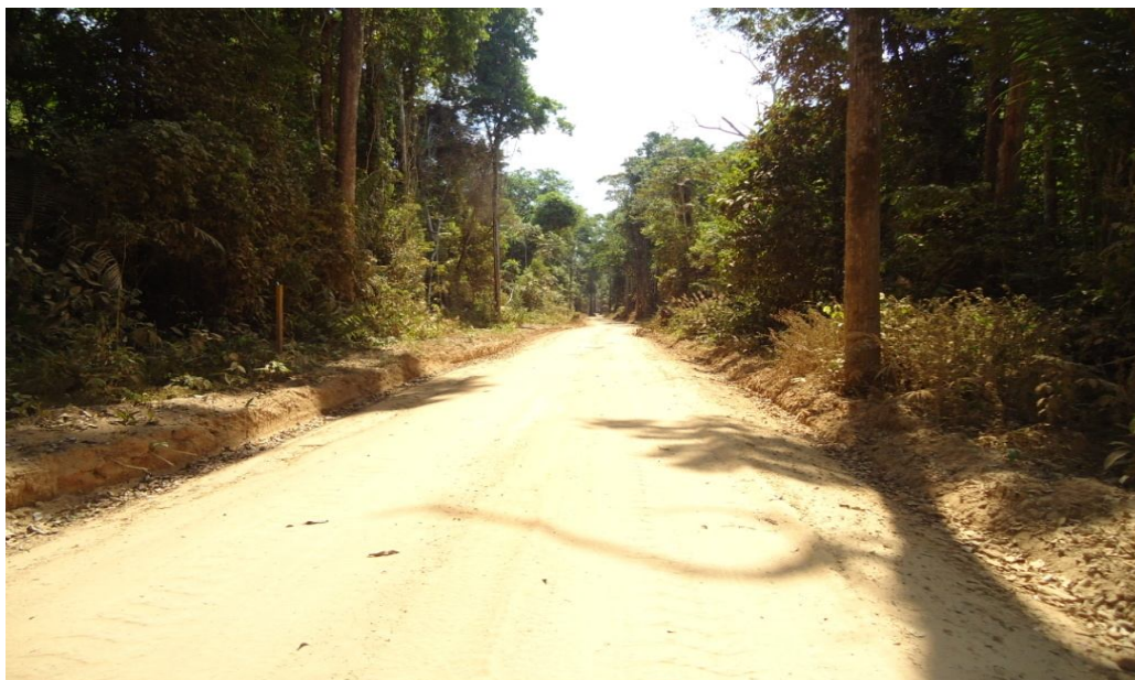
Foto 01 – Estrada cortando o centro da área onde está localizada a Terra indígena Maró Fonte: SILVA JÚNIOR, Gladstone Leonel da. Agosto, 2011.
