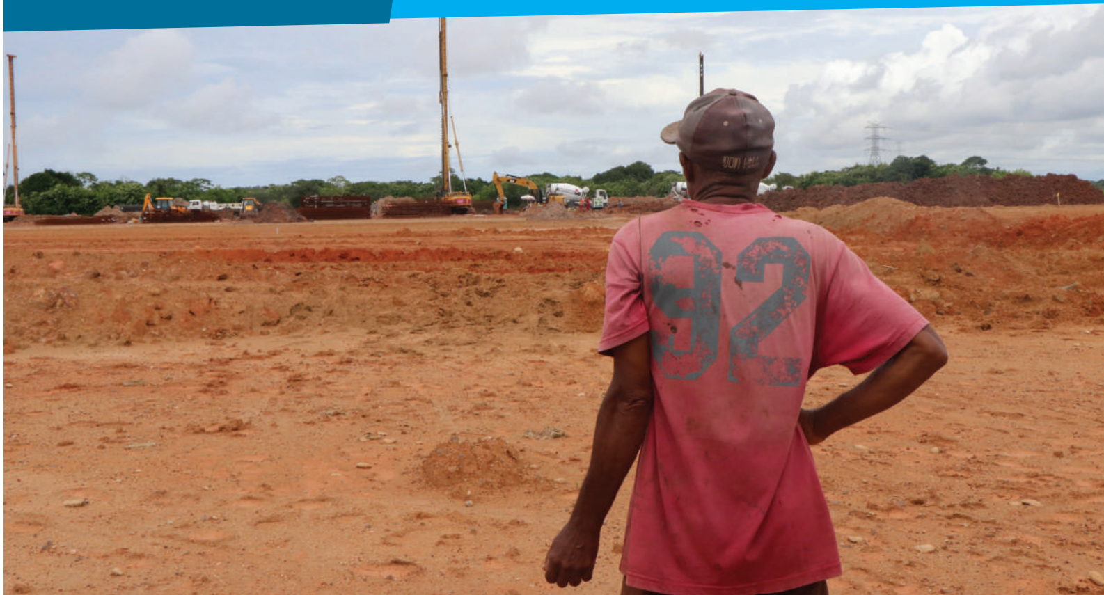
Posseiro do Engenho Jurissaca observando as obras de instalação da Aché.
