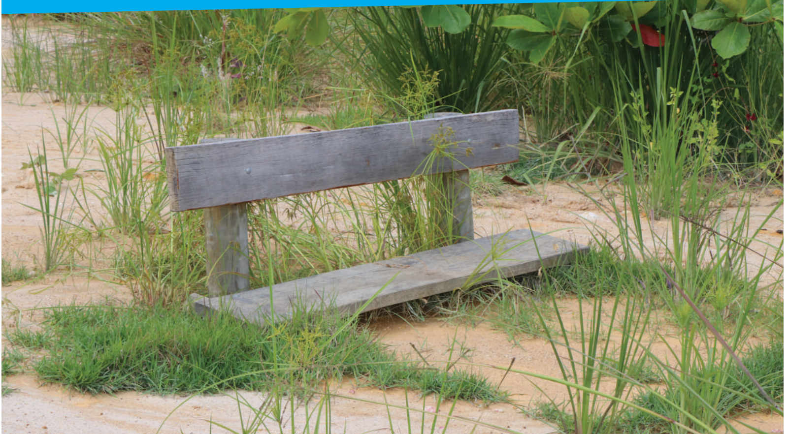
Área de convivência de Nova Vila Tatuoca coberta por barro proveniente da queda constante da barreira localizada ao lado do conjunto habitacional.
