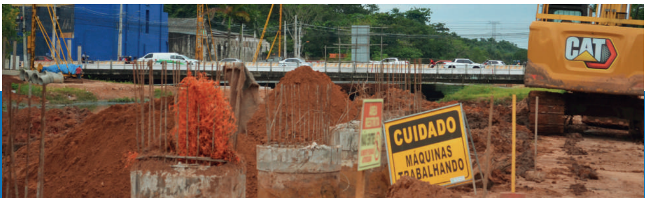
Foto: Obras nos territórios do Igarapé São Joaquim, julho de 2025.
