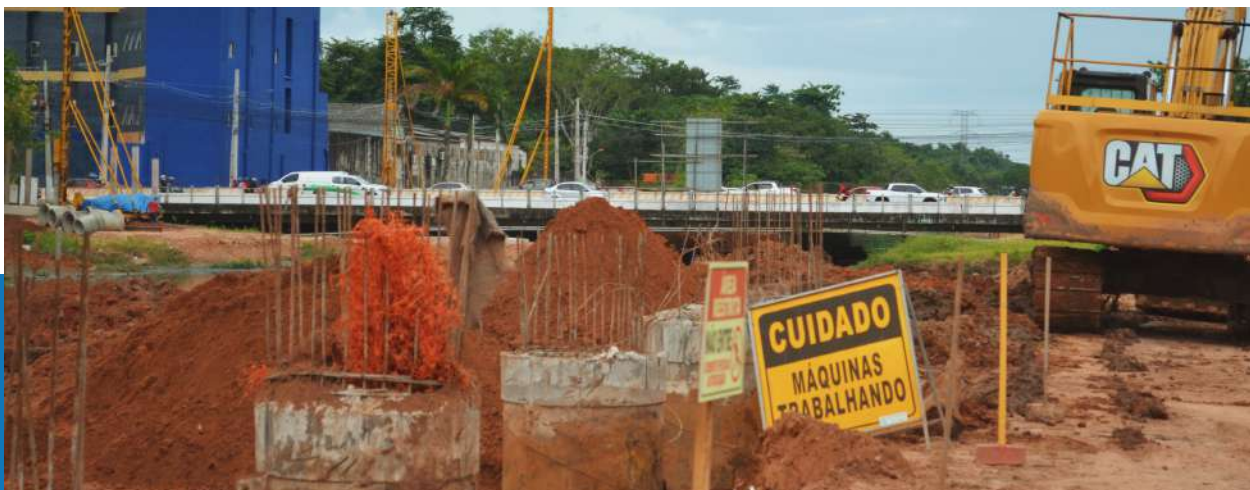
Foto: Obras nos territórios do Igarapé São Joaquim, julho de 2025.
