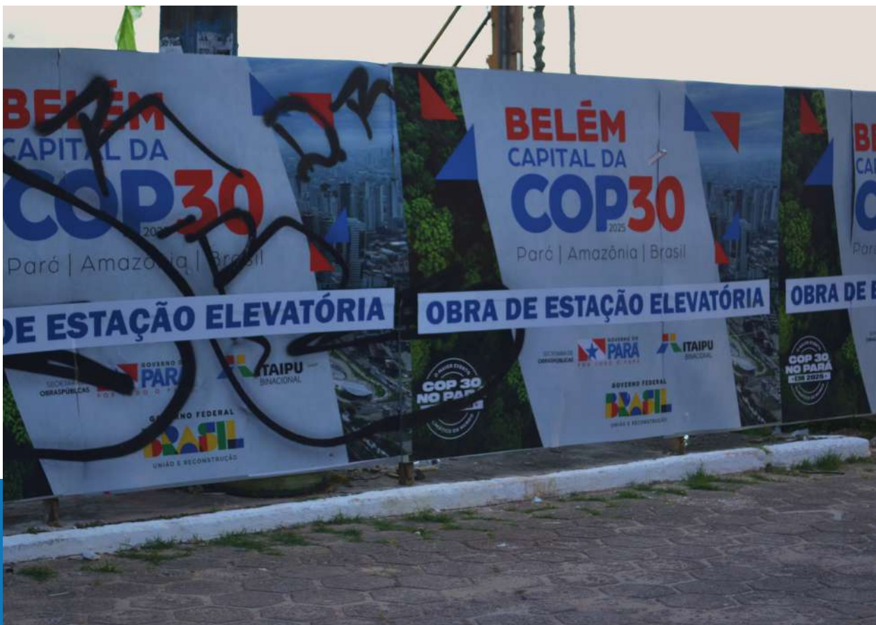
Foto: Obras da Estação Elevatória de Esgoto na Vila da Barca, julho de 2025.
