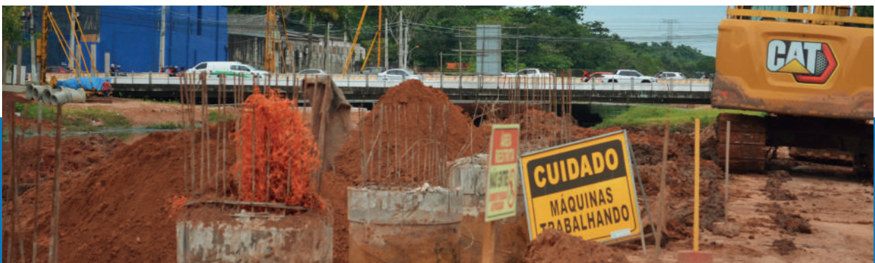
Foto: Obras en los territorios del Igarapé São Joaquim, julio de 2025.
