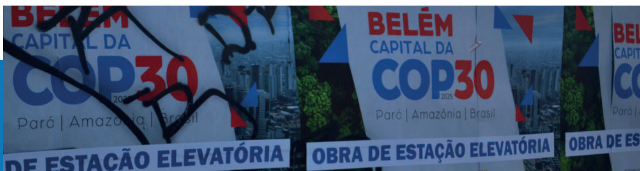
Foto: Obras de la Estación Elevadora de Aguas Residuales en Vila da Barca, julio de 2025.
