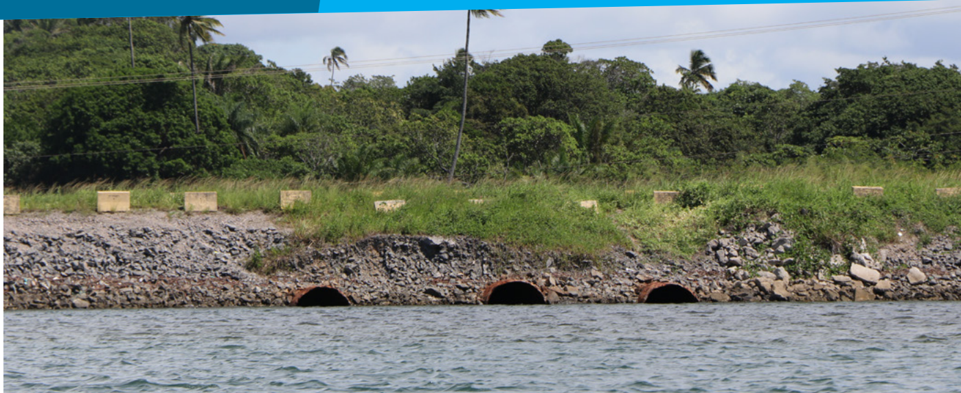
Barramento do Rio Tatuoca.
